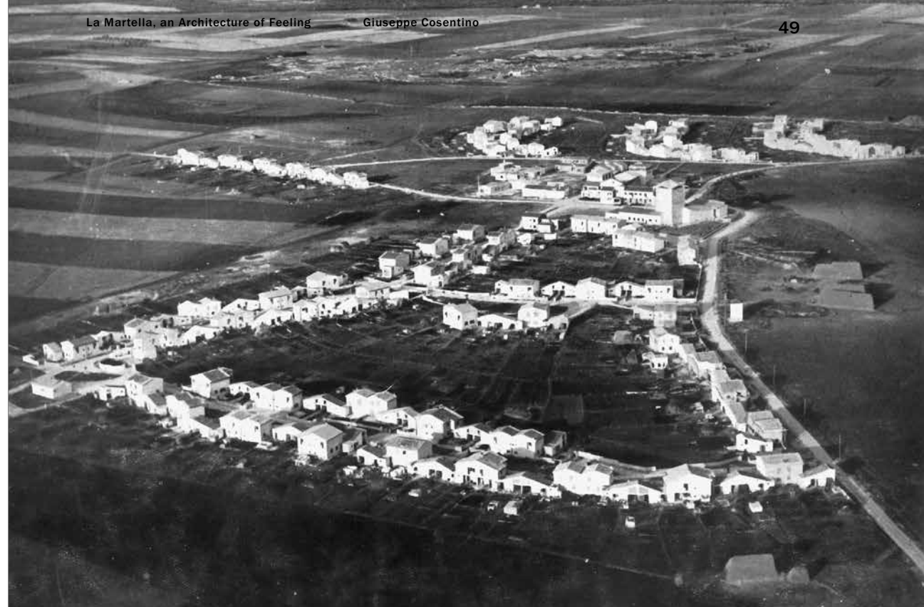
La Martella aerial view/ La Martella luchtfoto
