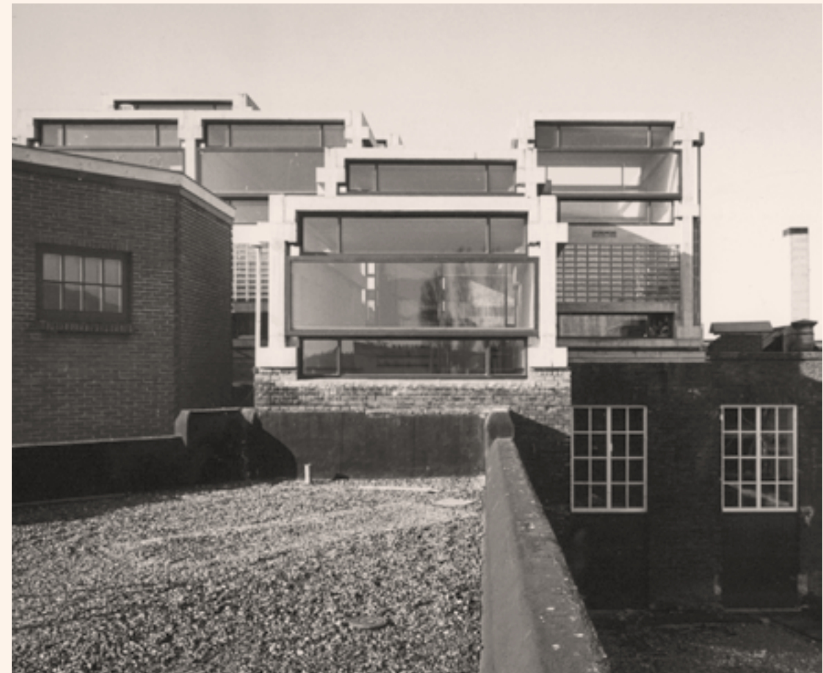
Extension to LinMij laundry, Amsterdam/ Uitbreiding wasserij LinMij, Amsterdam
