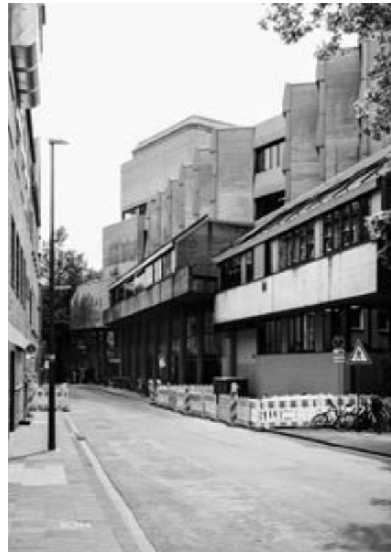
(HfM), façade/ gevel Im Krahenhof
