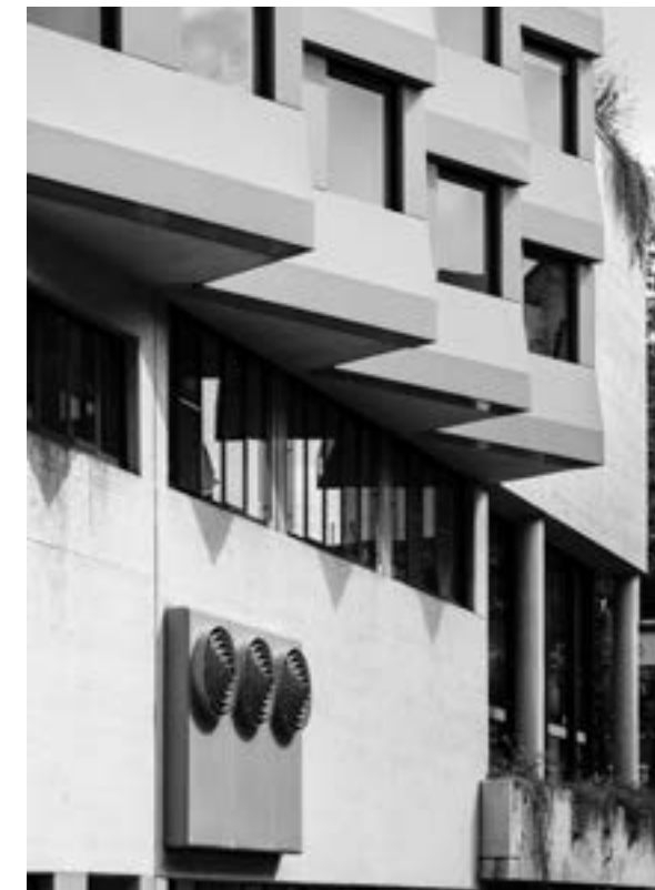
HfM, detail façade/ gevel Im Krahenhof
