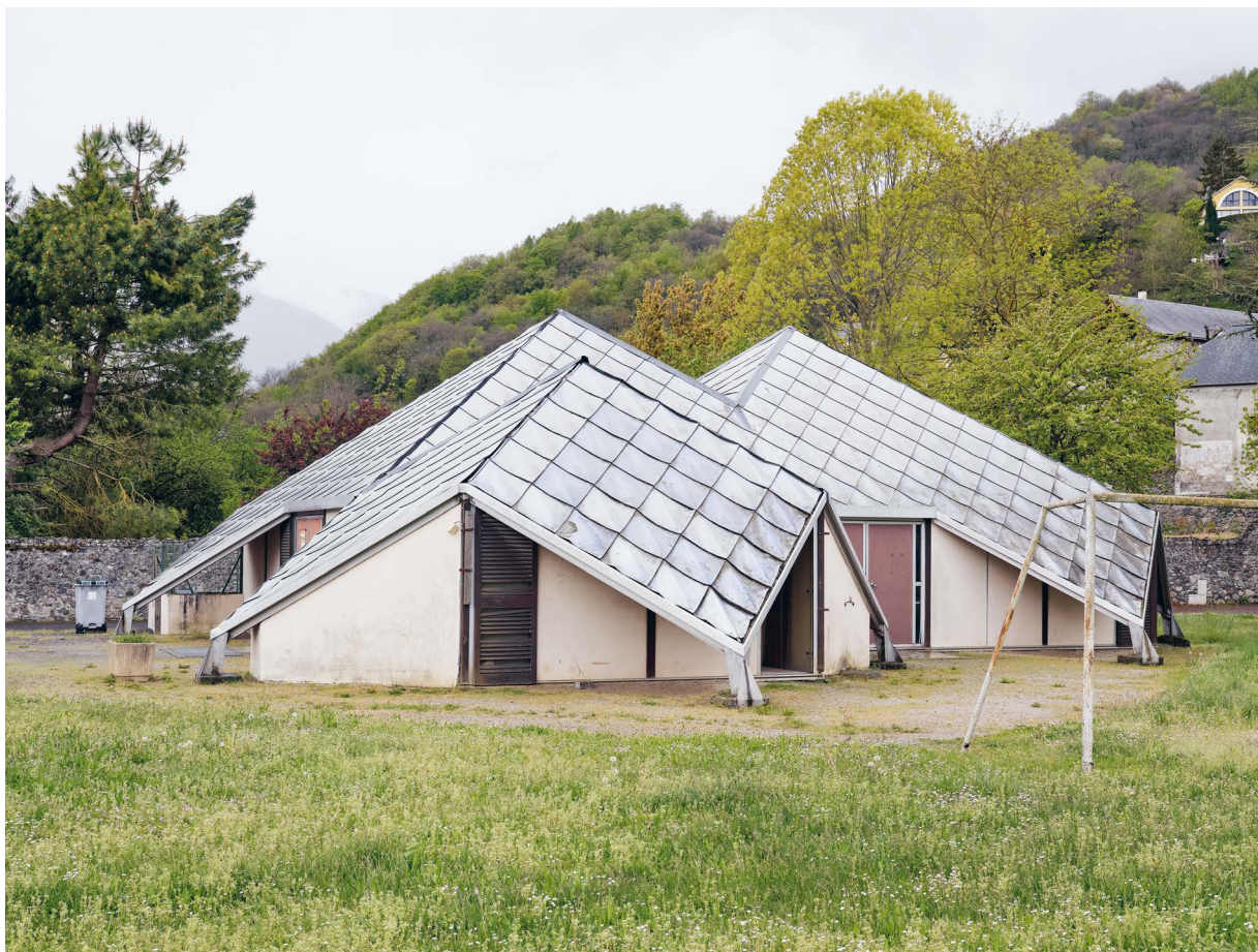
Multipurpose equipment/ multifunctionele voorziening 'Mille-Club', SEAL (Société d'Exploitation des Alliages Légers), model 2nd generation/ type tweede generatie, Ayzac-Ost, France/ Frankrijk
