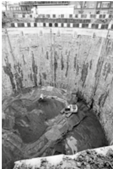
Excavation of a storm reservoir in Brussels excavating clay from Ypres/ Stormreservoir in Brussel waarbij klei uit Ieper wordt uitgegraven
