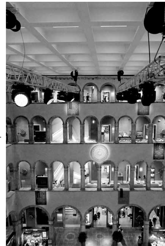
Fondaco dei Tedeschi, a glass lay-light was inserted under the pre-existing skylight / Binnenplein met het plafond uitgevoerd als lichtdoorlatend betonnen raster
