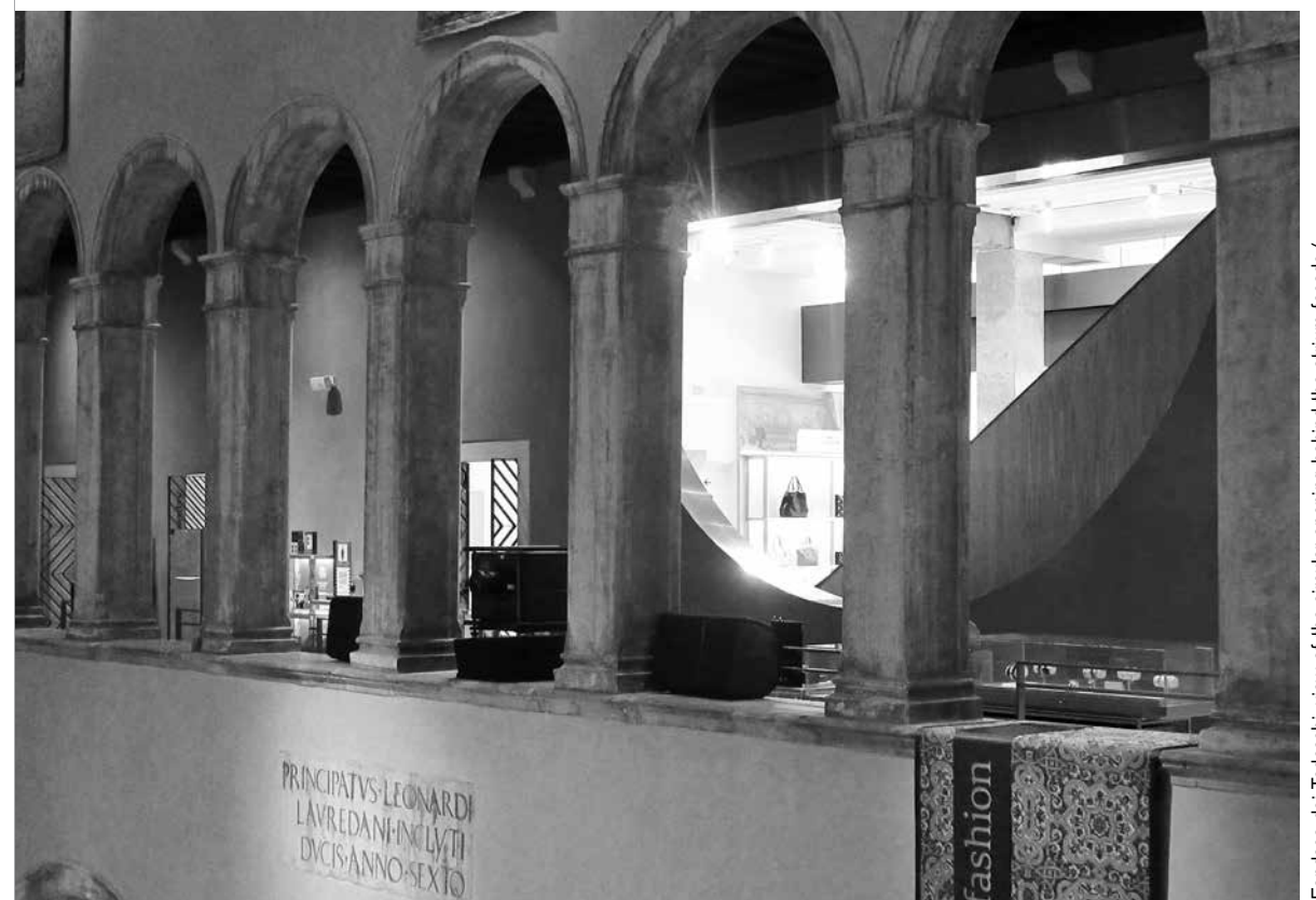
Fondaco dei Tedeschi, view of the circular opening behind the atrium facade / Zicht op de ronde opening achter de gevel van de binnenhof
