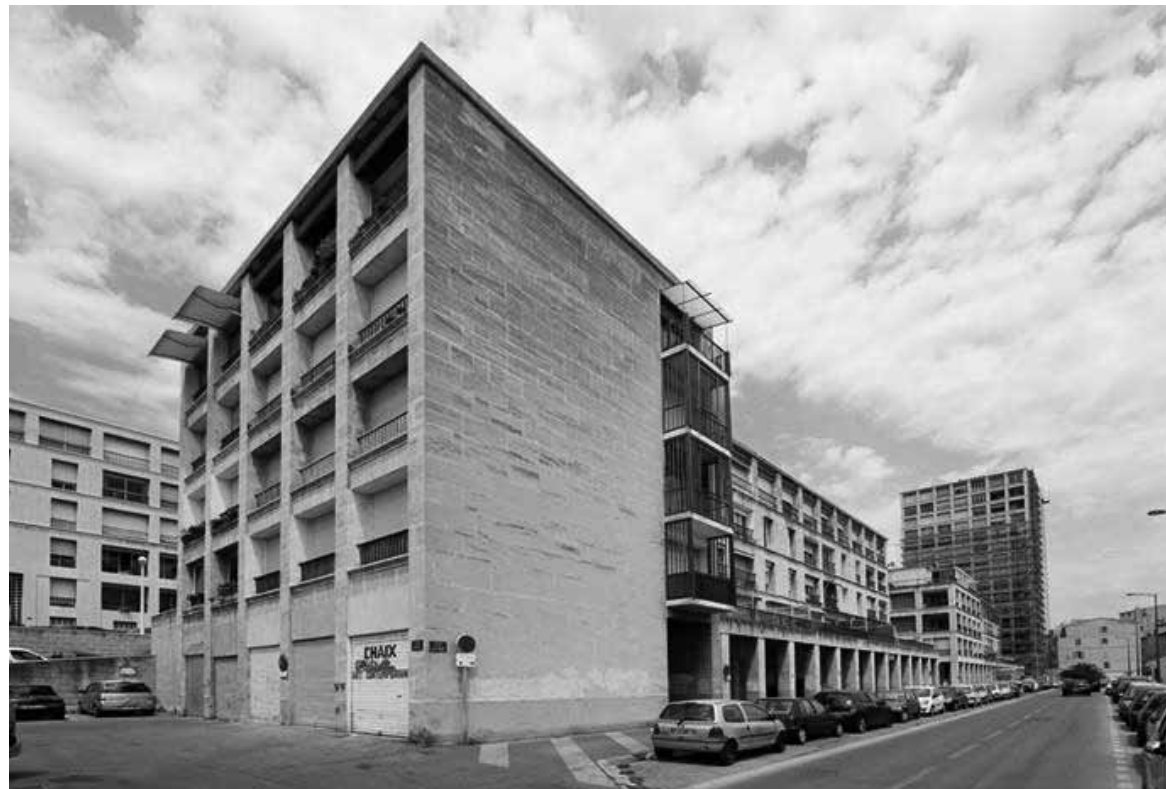
Fernand Pouillon, La Tourette, Marseilles Marseille, 1943-1953. De collonade of the project from the street De kollonade van het project vanaf de straat Photo Foto Jacqueline Poggi
