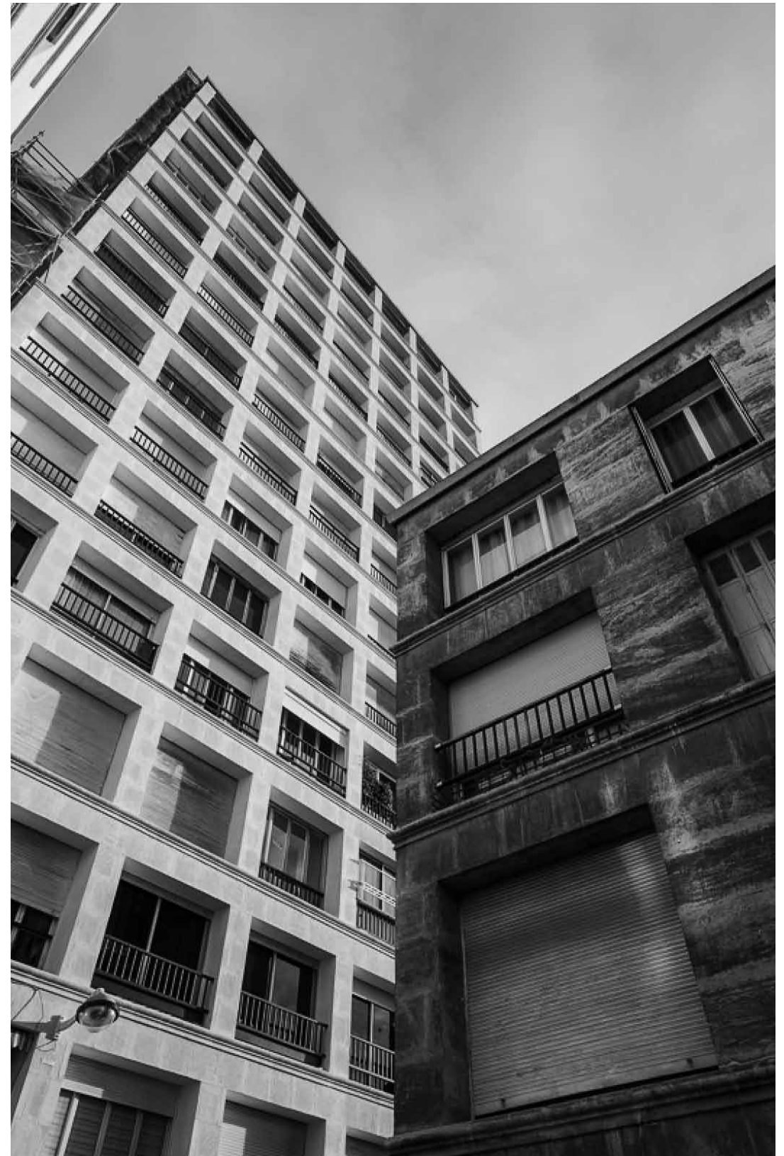
Tower with the tectonics of a frame De toren met de tektoniek van een skelet. Photo Foto Jacqueline Poggi
