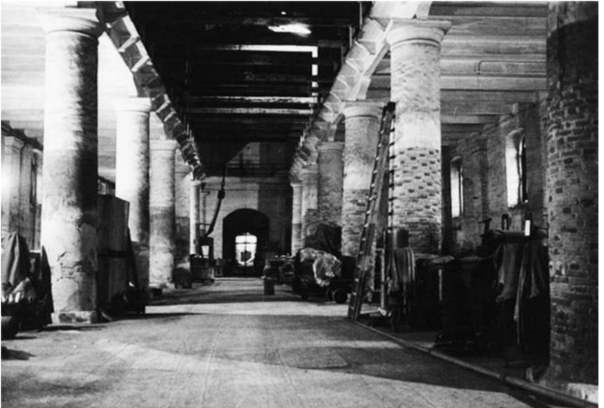
Corderia dell'Arsenale in Venetië, 1979 / Corderia dell'Arsenale di Venezia, 1979
