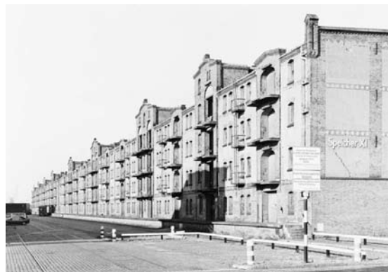
The Speicher XI before it was renovated / De Speicher XI voor de verbouwing
