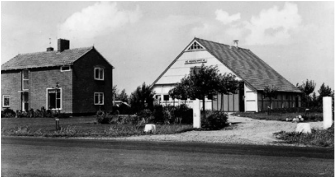
In de Noorddoostpolder werden 1000 identieke schokbetonnen schuren geplaatst, met schuine kappen en een abstracte opengewerkte gevel. De standaardschuur werd in 1947 ontworpen door het Amsterdamse architectenbureau Nielsen en Spruit; de NV Schokbeton uit Zwijndrecht vervaardigde standaard elementen in een voor dat doel opgerichte fabriek in Kampen. Hiermee stond de goothoogte, nokhoogte en breedte vast en was de schuur alleen in de lengte uit te breiden. / Thousands of identical prefabricated concrete barns with pitched roofs and abstract openwork façades were built in the Noorddoostpolder. The standard barn was designed in 1947 by the Amsterdam architecture firm Nielsen en Spruit; the NV Schokbeton company in Zwijndrecht produced standard prefab elements in a specially set up factory in Kampen. The height of gutter and ridge and the width were fixed; the length of the barn could be adjusted to the size of the farm.
