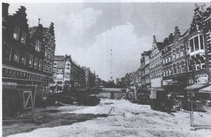
Schiedamseweg in Tussendijken; metroaanleg; foto Marco de Nood
