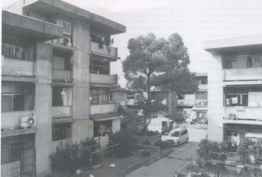
Woningbouw op het platform, 2001 / Housing on top of platform, 2001
