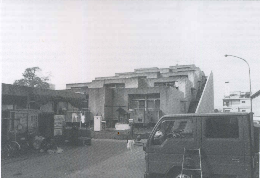
Boven op het auditorium / On top of the auditorium
