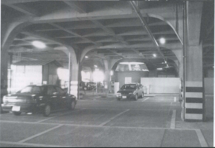
Onder het platform / Underneath the platform
