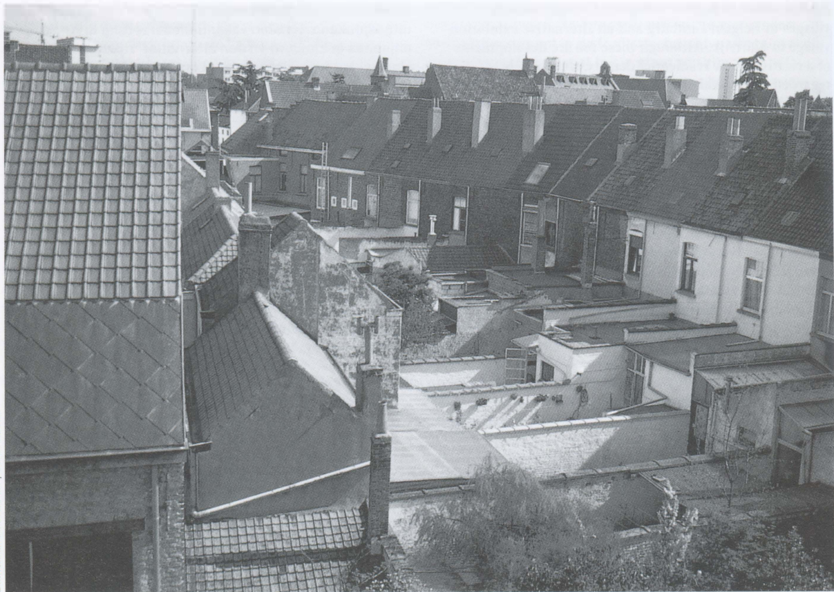
Binnenkant bouwblok | Block interior
