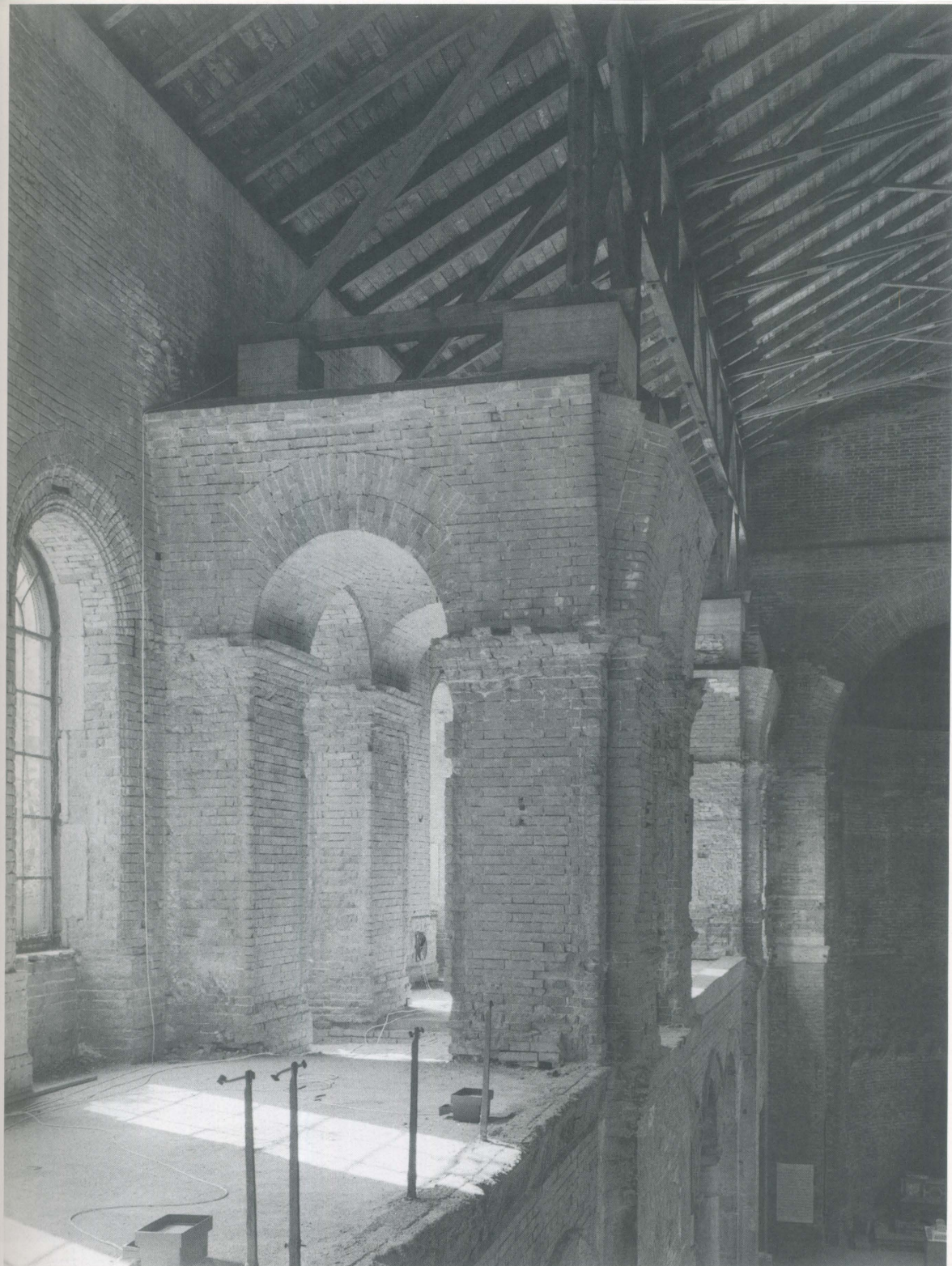
← ↑ Allerheiligenhofkirche 1971. Döllgast overdekte de oorlogsrüine van de barokke kerk met een houtconstructie. Het werk van Döllgast is inmiddels weer afgebroken, de kerk werd in originele staat teruggebracht / Döllgast covered the war ruin of the Baroque church by a timber construction. Now the work by Döllgast is demolished and the church has been rebuilt in its original state
