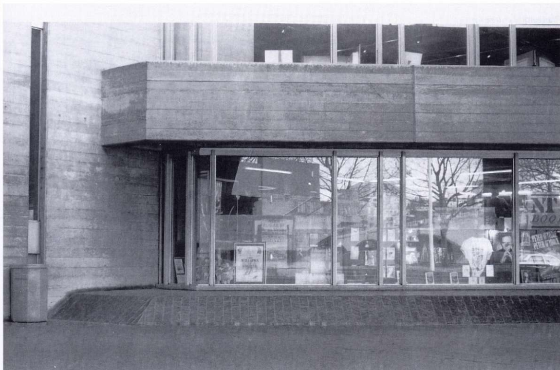
National Theatre, aansluiting boekwinkel op het trottoir
