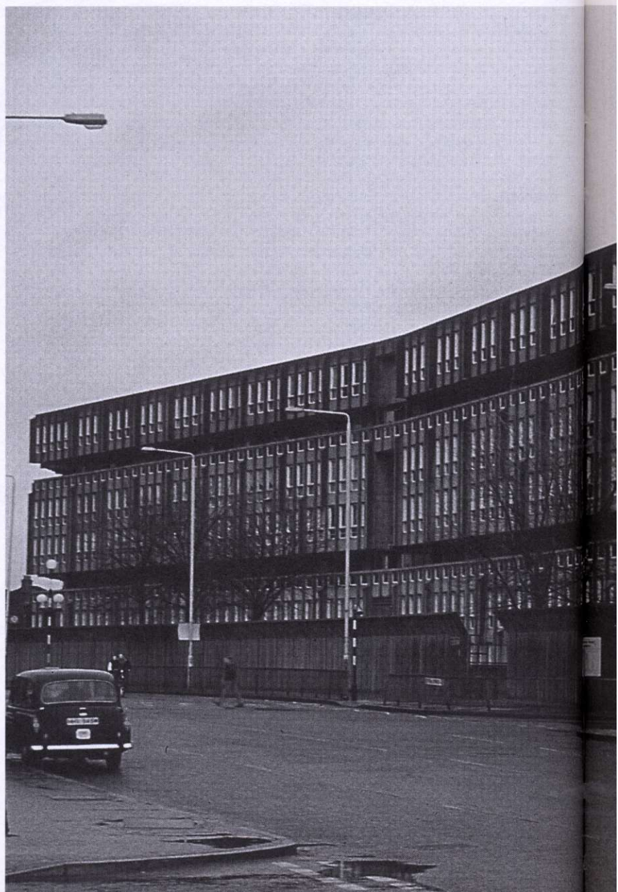
Robin Hood Gardens, gevel straatzijde
