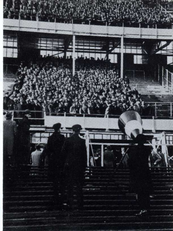
Rotterdam, Feijenoordstadion, belastingproef met werklozen, 1936
