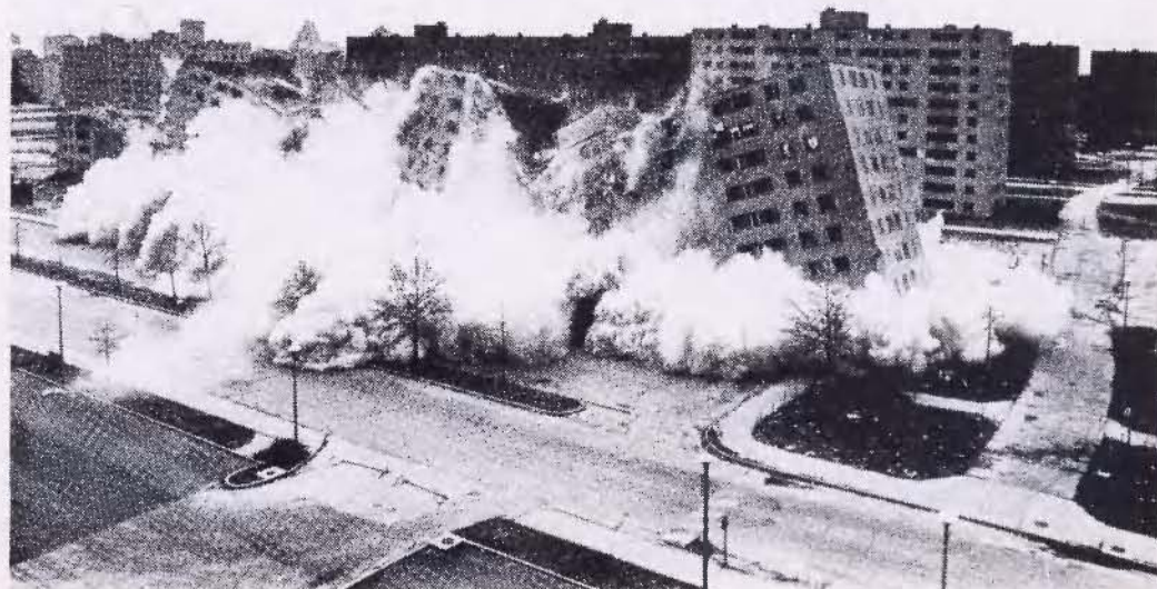
Het opblazen van de 20 jaar oude woningbouw in Pruitt-Igoe (St. Louis 1972)
